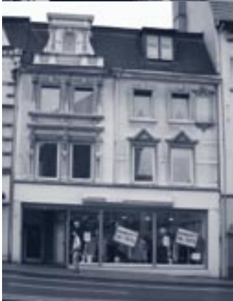
Beispiel für eine Fassadensanierung, die Die Hand-in-Hand-Werker GmbH bei diesem Gebäude am Theodor-Heuss-Ring ausführte.
