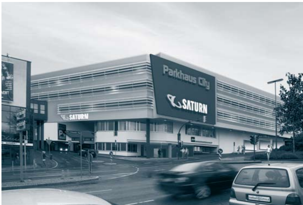
Im Zuge des Umbaus erhält das Parkhaus-City eine neue Fassadengestaltung mit waagerechten Glaslamellen und einer dominanten Werbefläche. Illustration: Brüggemann Schmidt
