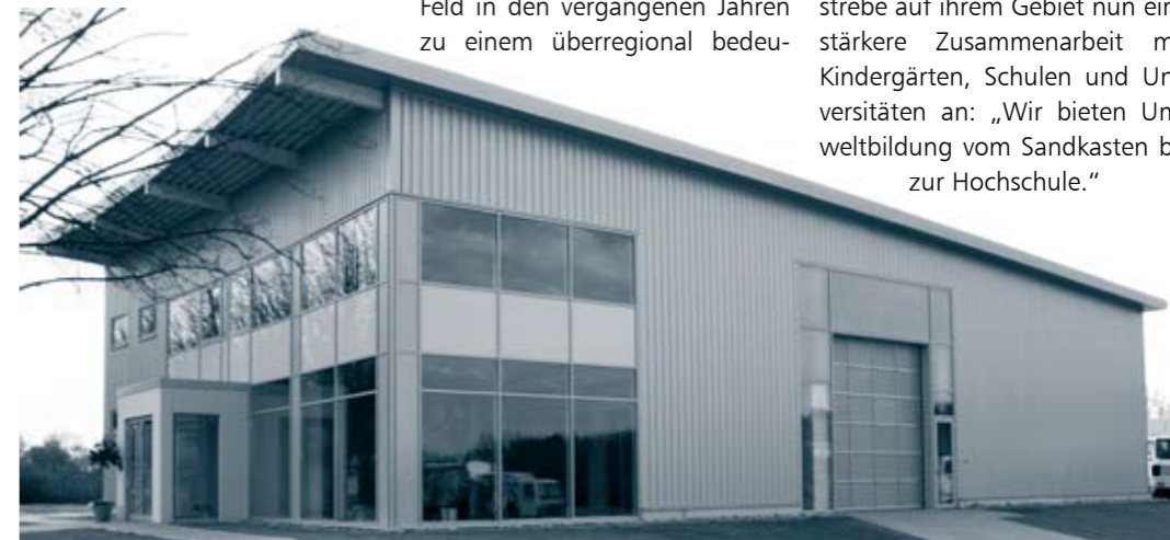
Außenansicht des Neubaus an der Max-Planck-Straße im Dröscheder Feld.
